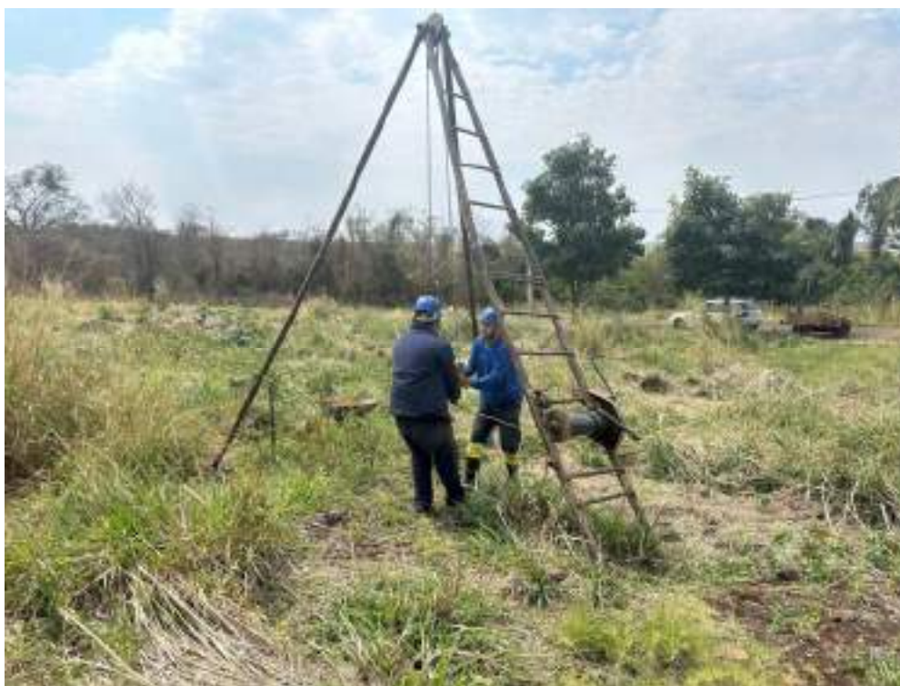
Foto 01 – Perfuração do furo SP-01. Foto Alexandre.
