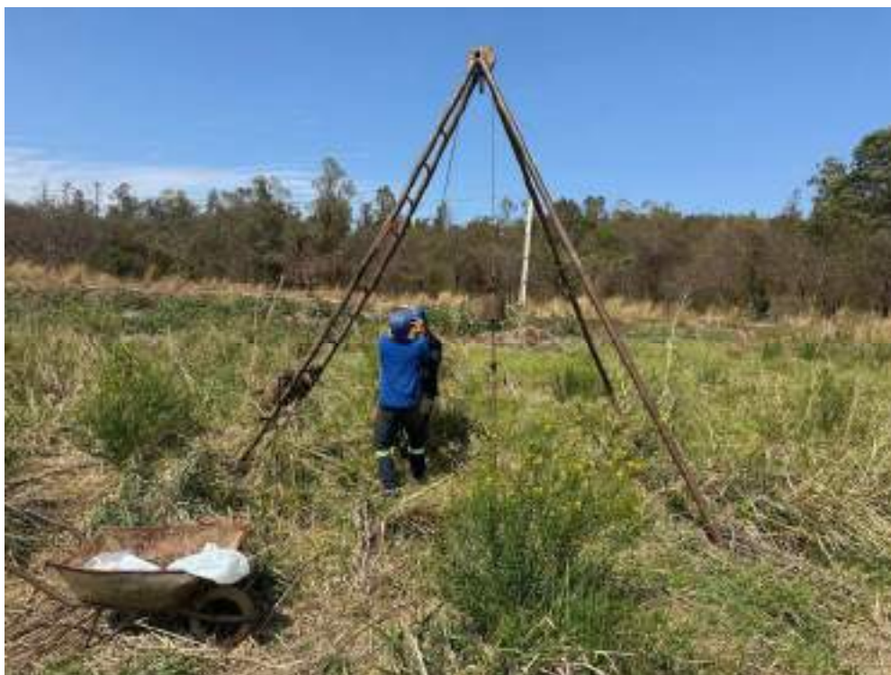
Foto 03 – Perfuração do furo SP-03. Foto Alexandre.
